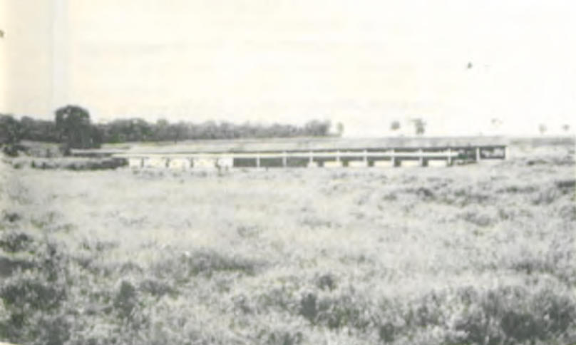
Instalações experimentais para confinamento.
