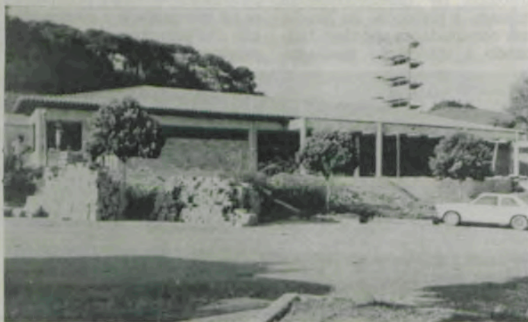
Vista parcial da Creche.
