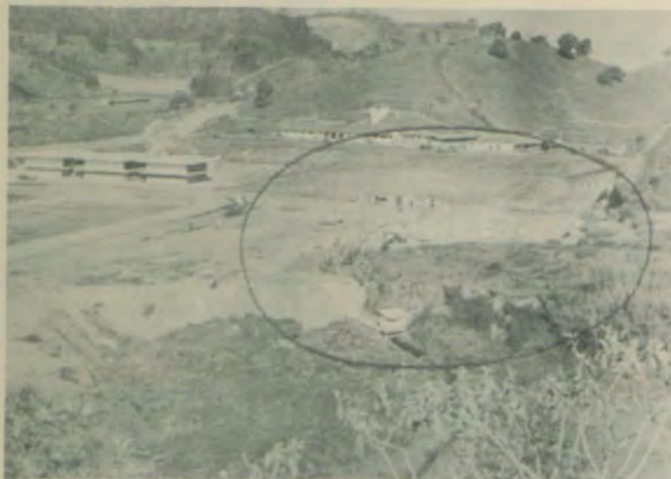
Começou a construção do Pavilhão de Ginásticas.
