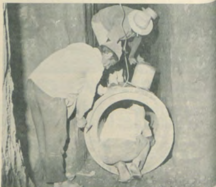
As canalizações estão em ritmo acelerado.
