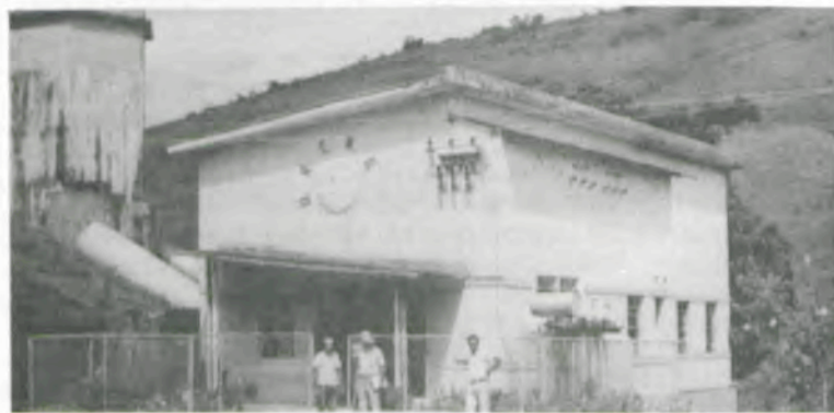
A casa de força da Usina da Casquinha.
