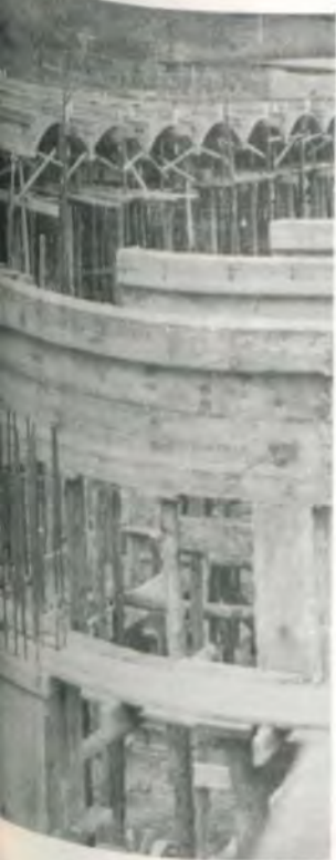
Construção do Laboratório de Zootecnia.
