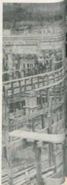
Estão adiantadas as obras do Laboratório de Grandes Animais.
