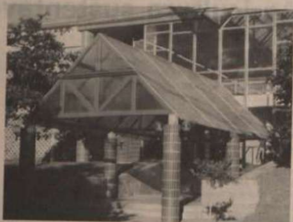
Instalações do Coluni no campus
