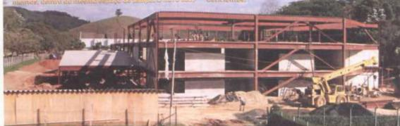
A estrutura metálica dos três pavimentos e parte da alvenaria já estão concluidas
