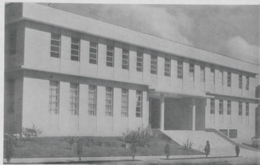
Prédio do D.E.T.A.L. (Laticínios). Sala de aulas teóricas dos diversificados em ZOOTECNIA.
